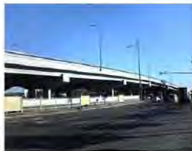
2008奥运会二、三、四环立交桥桥梁粉刷
