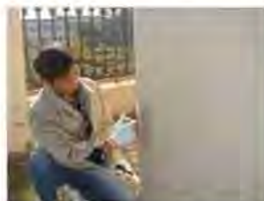
无机抗渗界面剂施工
