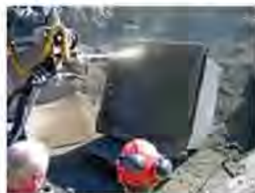
喷射混凝土
