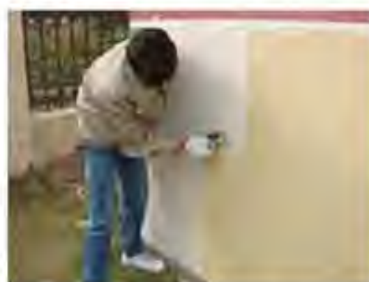
无机饰面砂浆刮抹
