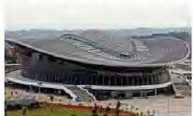
广西体育中心项目
