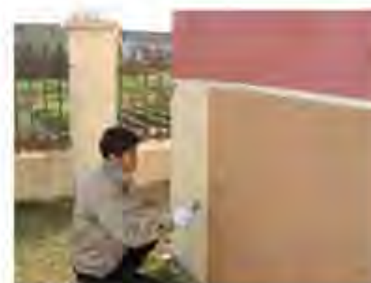
无机粉末涂料施工
