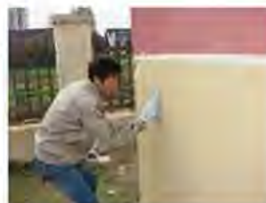
无机饰面砂浆打磨
