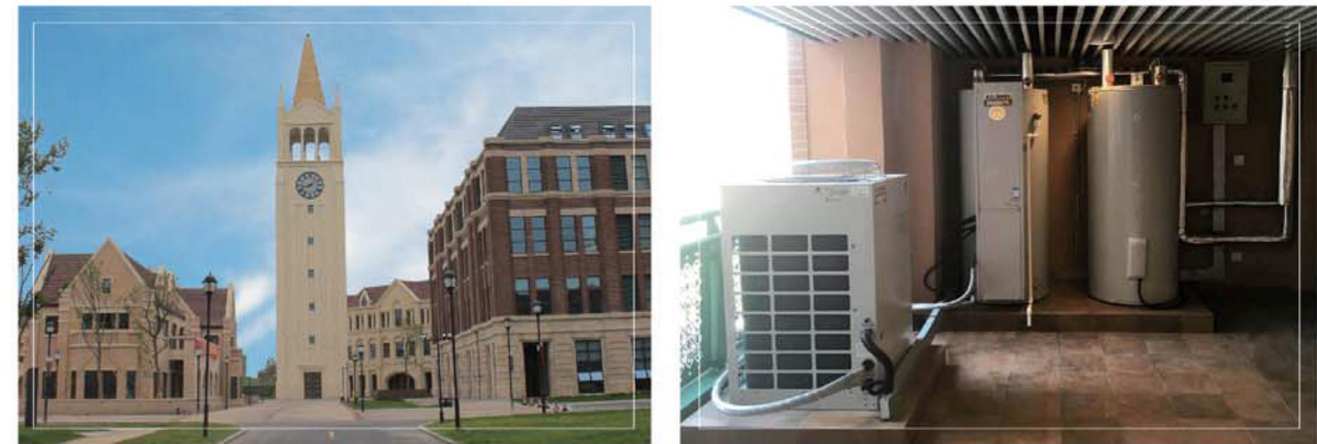
热水需求 学生宿舍洗浴、食堂热水 使用设备 36套CAHP-ST-18、32套CAHP-PI-42、36台储热水箱
