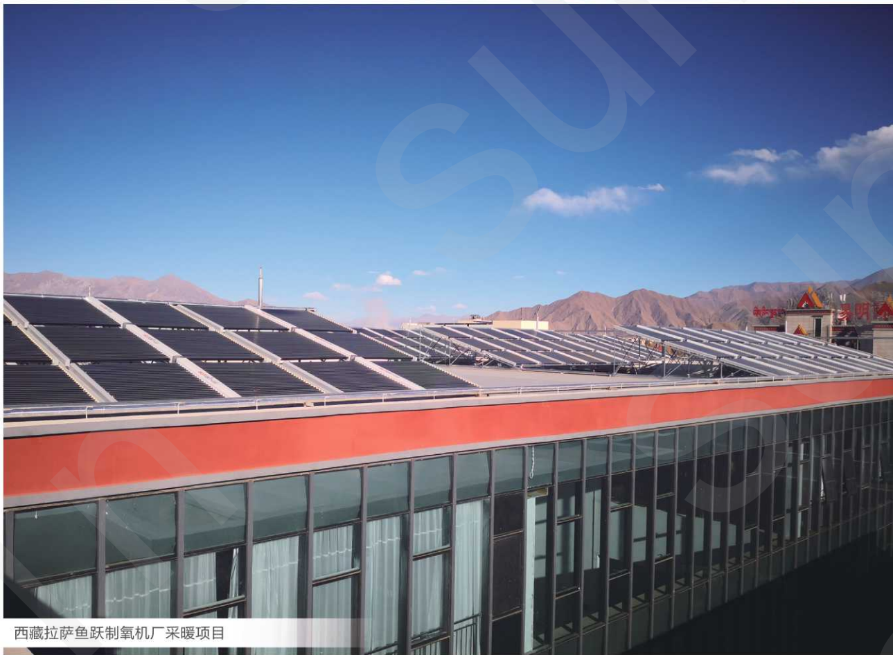
西藏拉萨曲水县才纳净土产业园温室大棚
