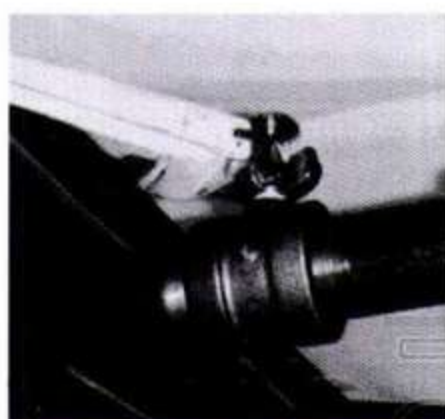
严禁使用非专用喷头安装工具
