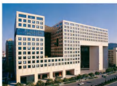
杭州电力大楼
