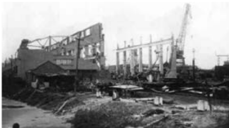
图 7-6 围护墙开裂外闪、局部或大面积倒塌
