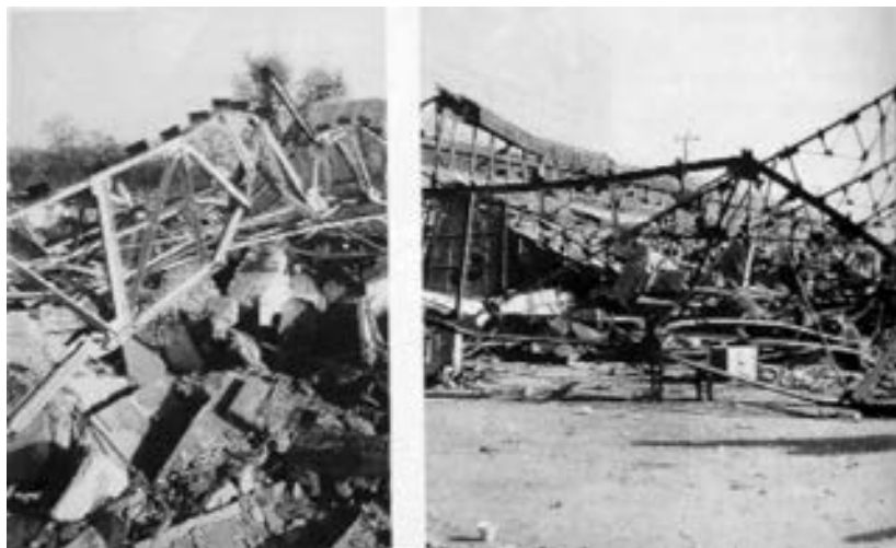
图 7-2 Π形天窗架与屋架连接点的破坏
