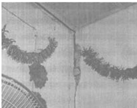
图 5-7 纵横墙连接破坏
