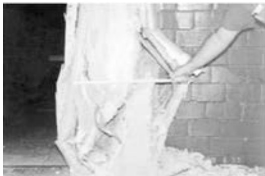
图 4-12 柱的剪切破坏
