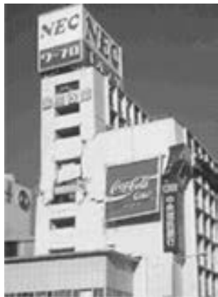
图 4-7 应力集中产生的震害
