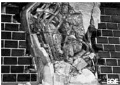
图 4-10 柱的破坏形式（一）
