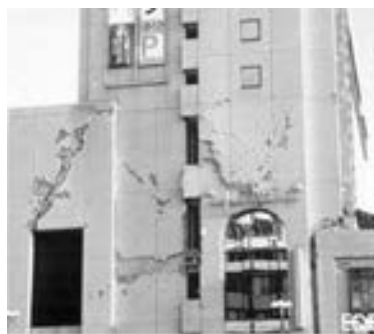
图 4-17 抗震墙的剪切破坏
