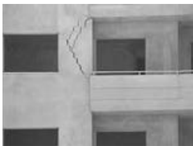
图 4-14 短柱破坏
