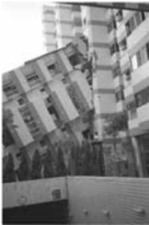
图 4-5 软弱底层房屋倒塌形式之一（倾倒）
