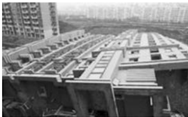
图 5-1 楼房整体倒塌
