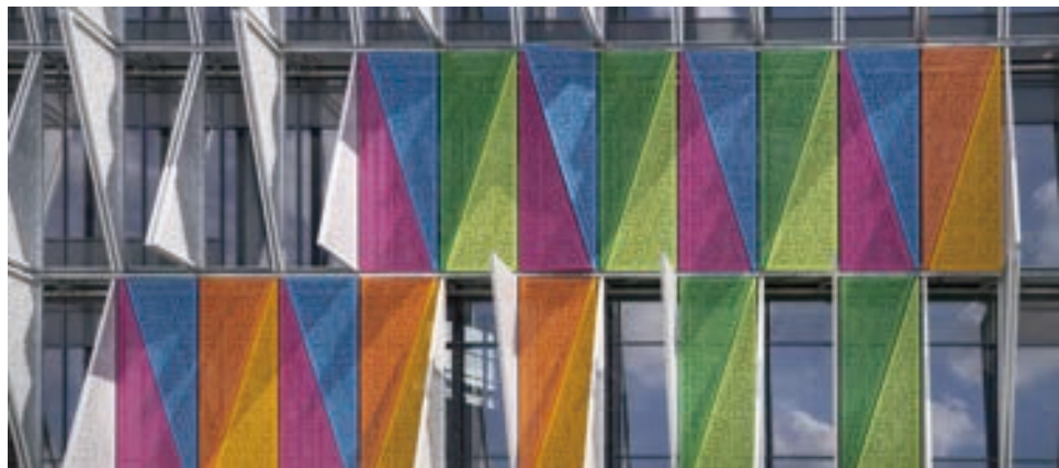
图 4-11 可转动的遮阳片能灵活控制能量和光线的进出
