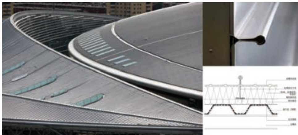
图 5-20 金属屋面高立边锁扣系统构造
