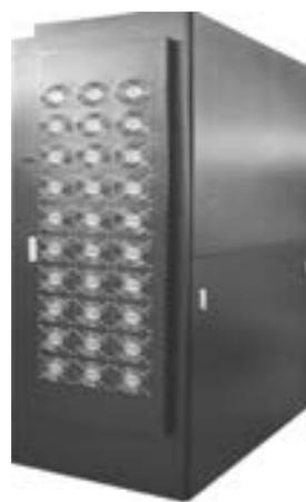
图 8-6 热管背板机柜实物图
