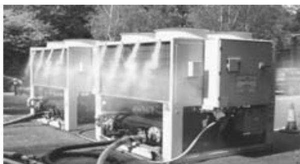
图 1-20 喷雾型蒸发式冷凝器
