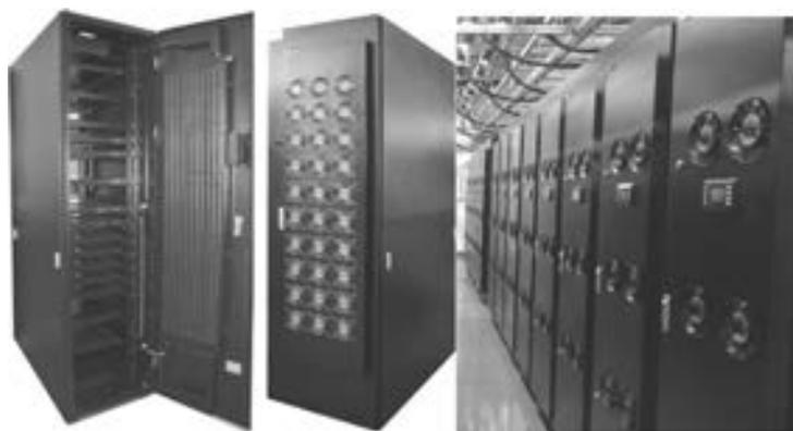
图 4-11 热管背板空调机柜在数据中心机房中的现场安装图
