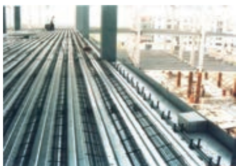
图 1-57 压型钢板组合楼板
