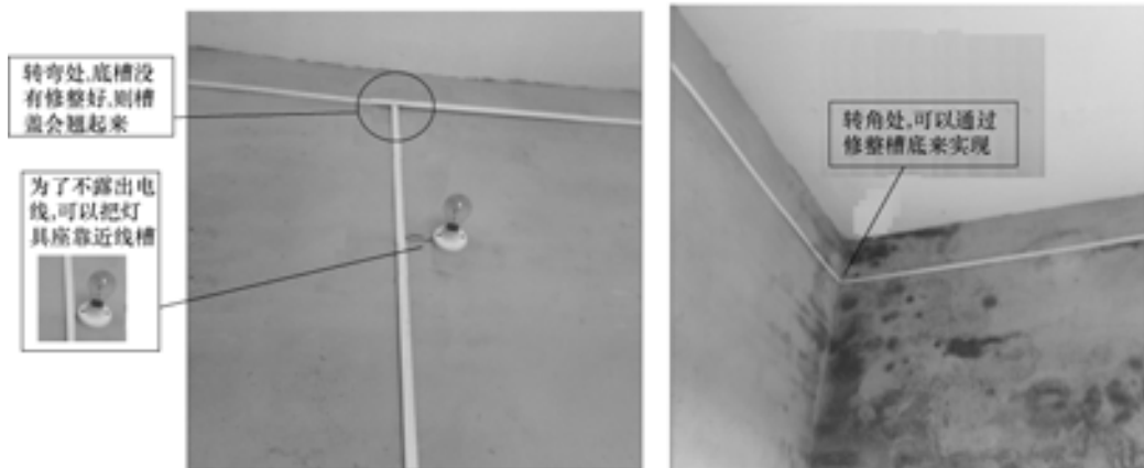
图 4-70 塑料线槽不带附件的安装图例
