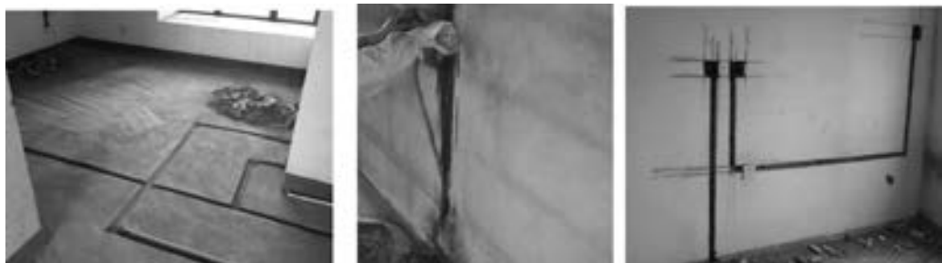
图 4-59 开槽的图例
