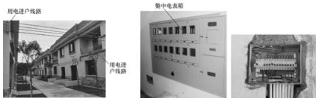
图 4-53 用电进户线路节点
