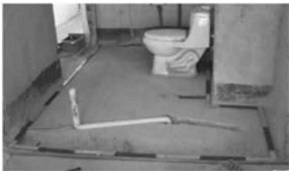
图 4-81 暗装等电位连接线
