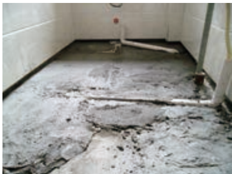
图6-23 水泥浆加固管道
