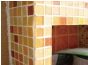
图6-33 阳角玻璃锦砖铺贴工艺
