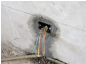
图6-22 安装插座的位置
