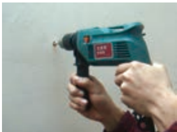
图6-47 墙面钻孔
