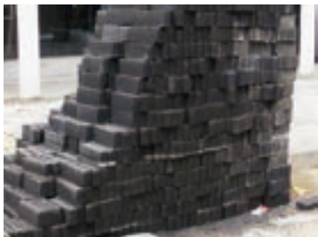
图5-15 粉煤灰砖湿水
