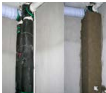
图6-16 包砌落水管
