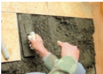
图6-32 铺设水泥砂浆及瓷砖
