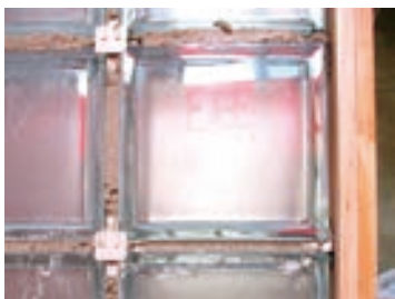
图6-37 水泥砂浆填补缝隙
