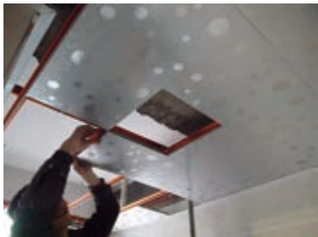
图6-41 安装金属扣板
