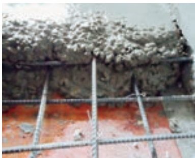
图6-13 水泥砂浆覆盖钢筋网架
