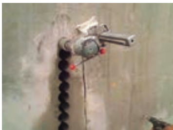
图6-12 密集钻孔
