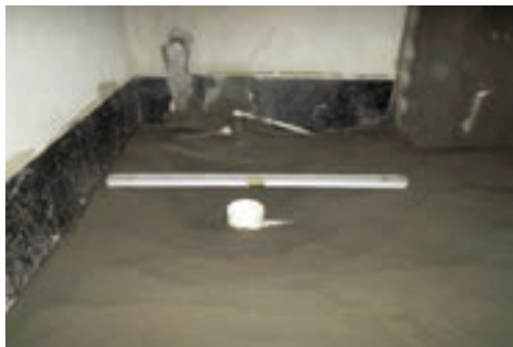
图6-25 水平尺校正
