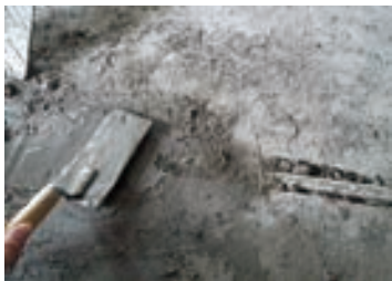
图6-18 水泥浆覆盖水管
