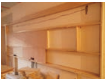
图6-45 安装罩面板
