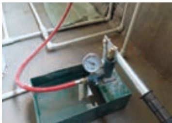
图6-17 打压器给水管试压
