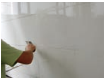
图6-30 填补瓷砖缝隙
