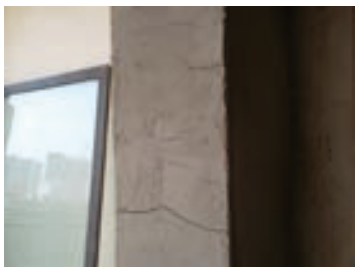
图6-5 墙面裂缝
