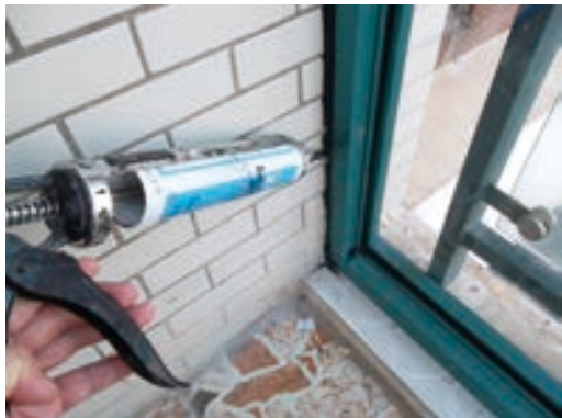
图5-29 玻璃胶填补缝隙
