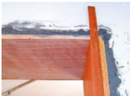
图6-56 洞口垂直检测
