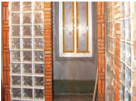
图6-35 玻璃砖做隔墙
