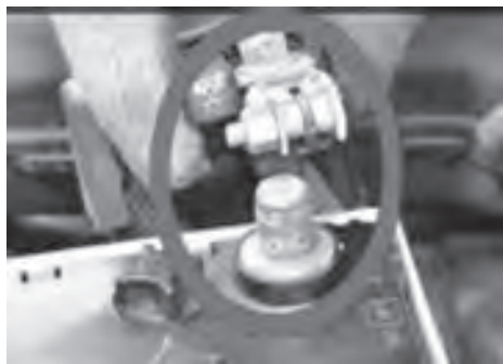
图11-17 去除极柱上的腐蚀物
